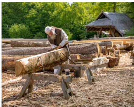
Auf der Klosterbaustelle Campus Galli wird mit alten Baumethoden gearbeitet
